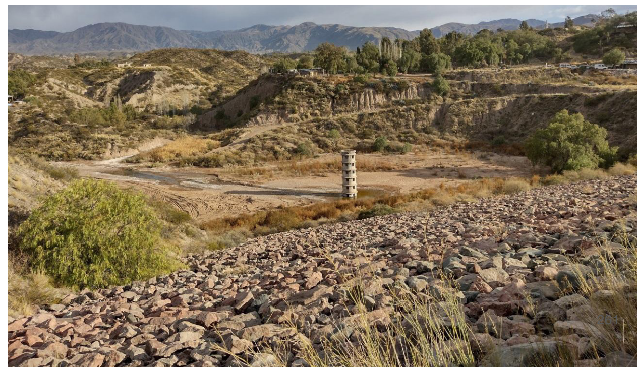
Figura 1. El Zanjón Frías en la zona de nacientes e infraestructuras de control. Fuente: G. Pastor
