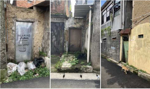
Gambar Kondisi Pintu Brandgang sebelum direnovasi
