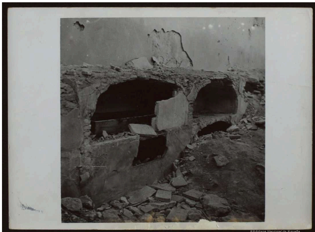
Figure 3: Marqués Santa M a del Villar, "Cementerio profanado por los rojos en el convento de Agustinas, Belchite"
