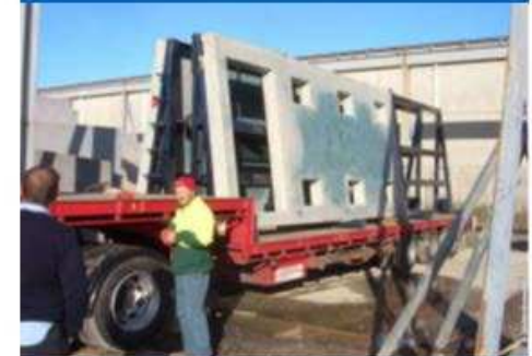
Precast walls (AU)
