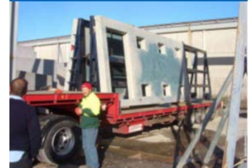
Precast walls (AU)
